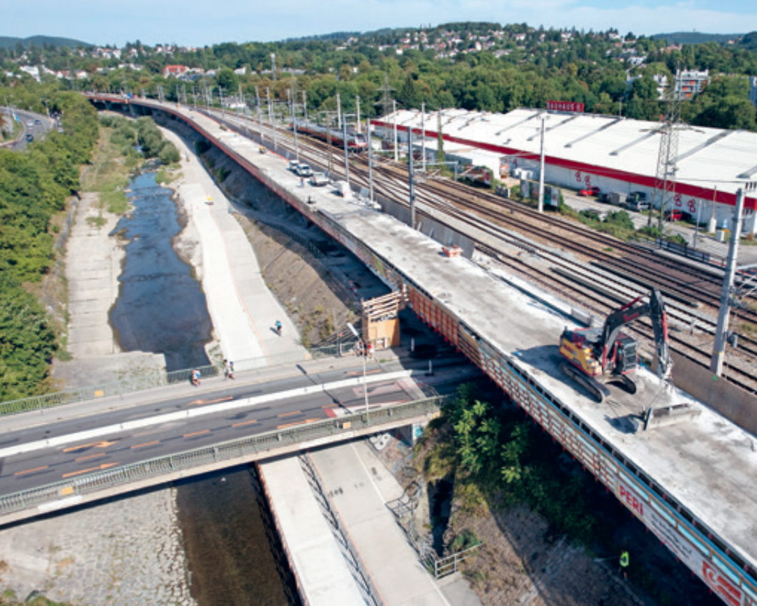
Die Abbrucharbeiten erfolgen in Zusammenarbeit mit der Firma Tiefbau Burger. Die Betonelemente werden während des Schneidevorgangs vom Bagger gesichert und vor dem Abtransport mit einer Betonzange zerkleinert.
