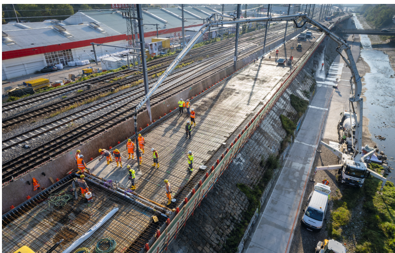
Die Linienbaustelle grenzt stadtauswärts auf der rechten Seite direkt an die ÖBB-Bahnstrecke – im linken Bereich liegt der Wienfluss mit einem Fuß- und Radfahrerweg.
