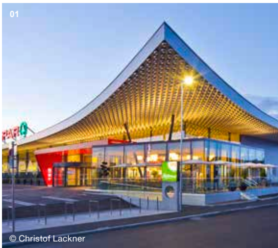
01 Interspar, Amstetten | Montage der Holzunterkonstruktion inklusive Bohrungen und 3.500 Stk. Edelstahlkugeln
